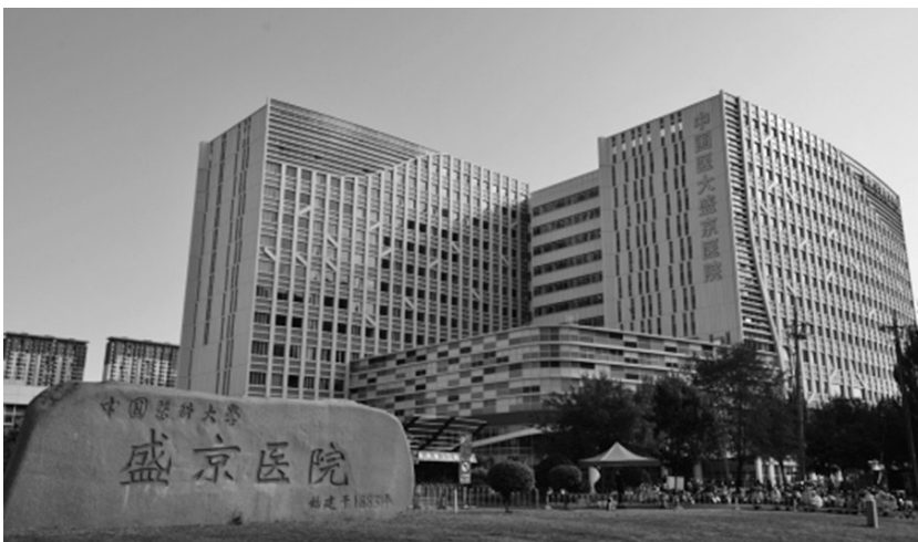
盛京医院沈北院区·国家儿童医学中心大楼。
