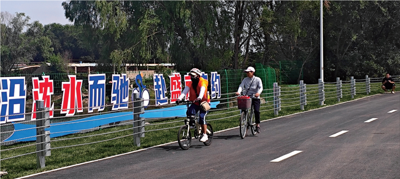
沈阳市沈河区浑河北岸滨水路部分路段经抢修,于8月28日正式恢复通行。 本报记者 王迪 摄
