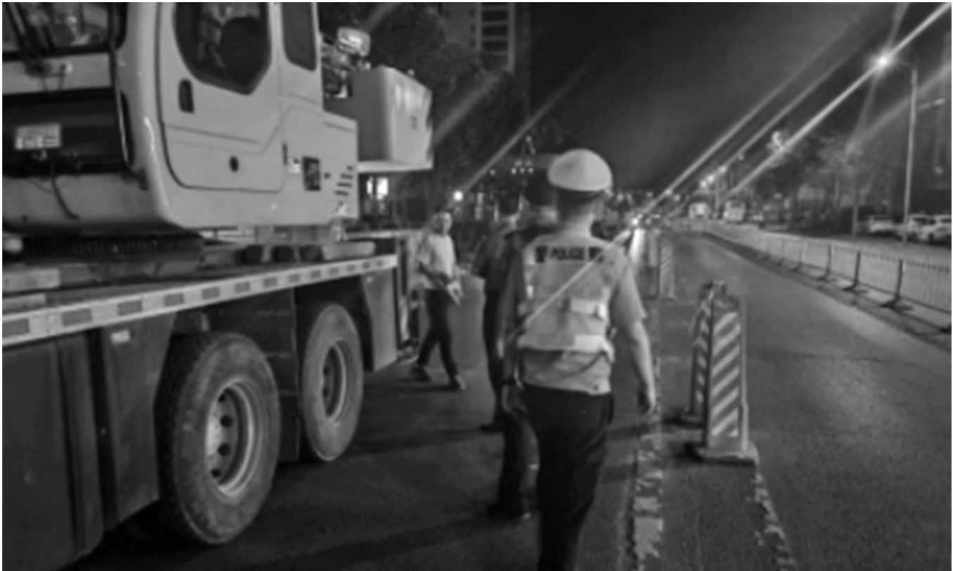
连日来,沈阳市城市管理综合行政执法局苏家屯区执法分局深化警城联动工作机制,联合属地交警部门开展道路施工乱象专项整治行动。 沈阳市城管执法局供图
