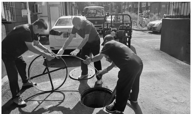
经过连续多次的反复作业，顽固堵塞的下水管道终于恢复畅通。大东区供图
