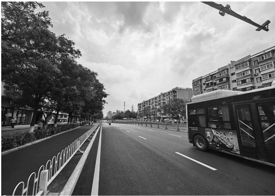
“驼峰”两端跟原有路面平顺衔接,开车经过几乎感觉不到颠簸。 本报记者 马巧慧 摄
