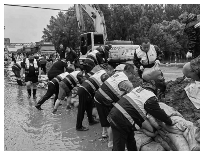
50余名青年志愿者全力投入筑堤护岸抢险工作。
