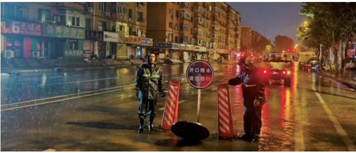
提前开启雨水井盖、窨井盖拓宽收水断面。
