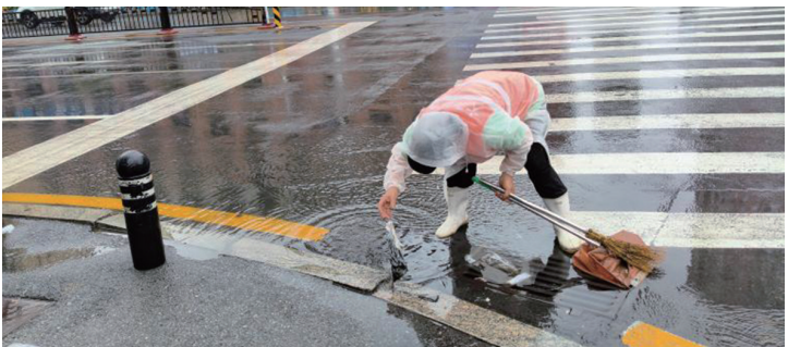
集中人力清掏排水井口落叶、垃圾等杂物。
