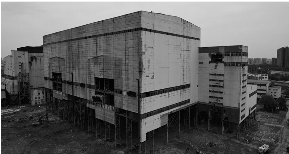
6月13日,沈海热电厂1号锅炉及其所在的厂房终于卸下了满身风尘。 大东区供图
