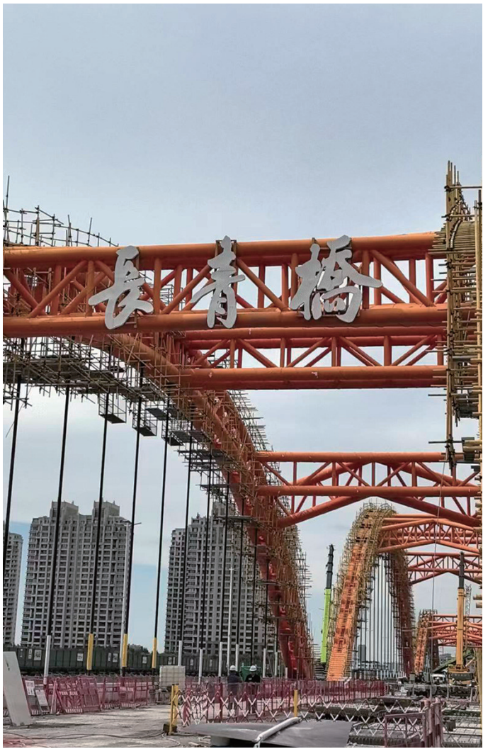
沈阳长青桥主桥加固改造项目，目前已全面进入桥面板更换的关键阶段，预计8月初完成全部桥面板更换。
