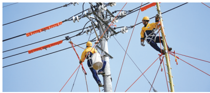
工作人员在电杆上开展引流线搭接工作。 陈龙 摄
