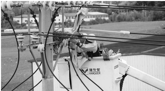
工作人员细致稳妥开展作业，全程做到不影响用户正常用电、不破坏周边环境、不惊扰鸟类栖息。
