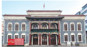
沈阳审判日本战犯法庭旧址陈列馆维修闭馆。
