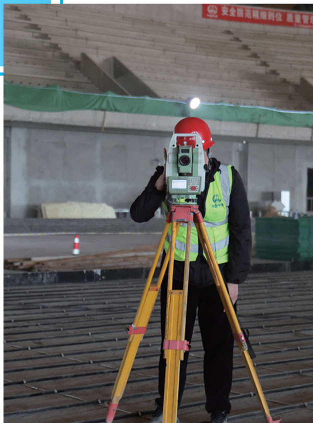
中铁四局工程技术人员在速滑馆进行工程测量作业。
