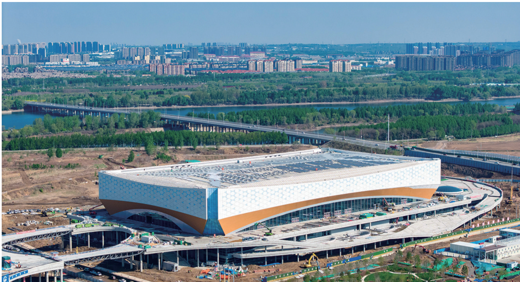
建设中的沈阳王家湾冰上运动中心速滑馆(无人机照片)。
