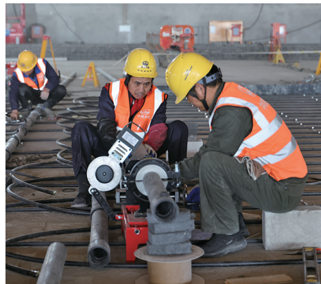
技术人员在进行冰场加热层防冻盘管安装。
