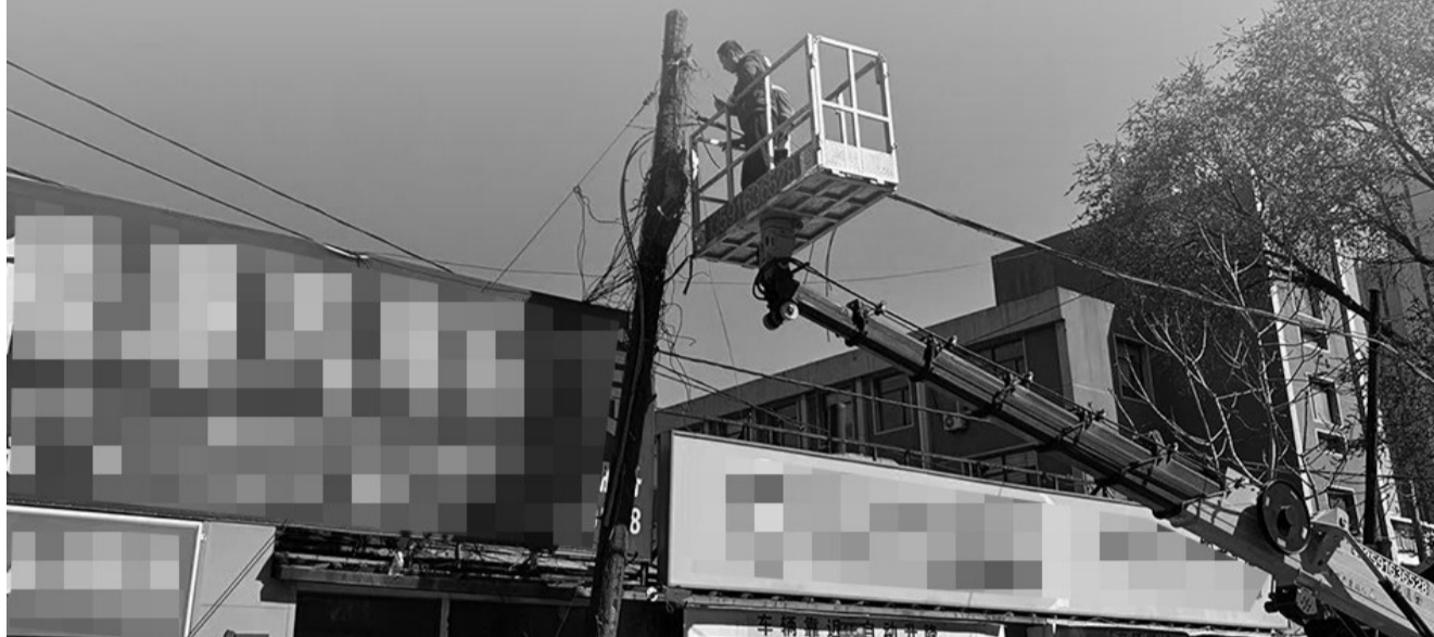
沈阳市大东区集中力量开展废弃线杆、老旧线缆专项清拆整治行动。
