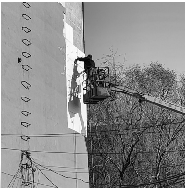
维修人员到现场对保温层进行维修。 受访者供图
