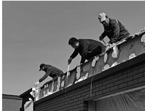
工作人员在顶楼拆除违建。本报记者 吴章杰 摄
