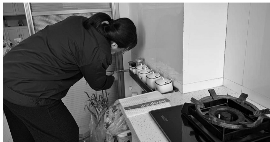
设计师来到居民家中,现场测量了改造管道的具体尺寸。
