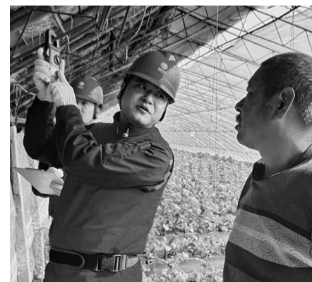
工作人员穿梭于棚间,为早春黄瓜育苗提供可靠电力保障。受访者供图
