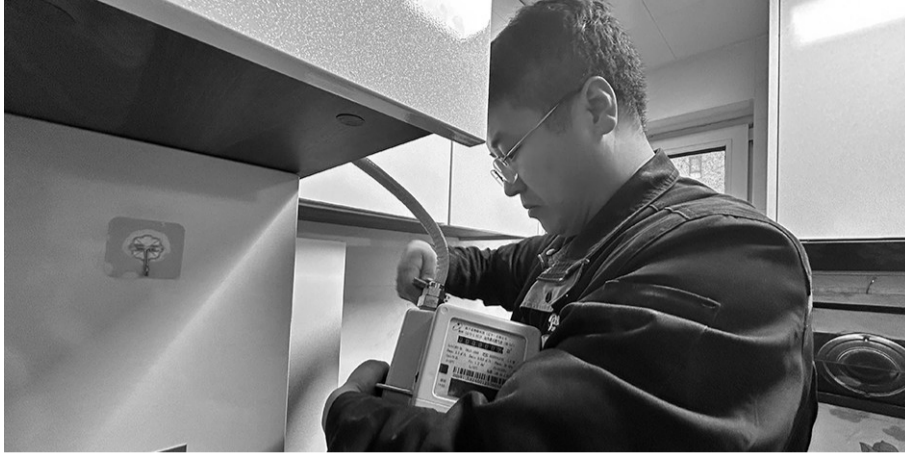
燃气公司工作人员为业主安装燃气表。
