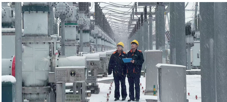
12月23日，国网辽阳供电公司员工在首山220千伏变电站，重点检查充气设备气体压力，保障电网安全稳定运行。
