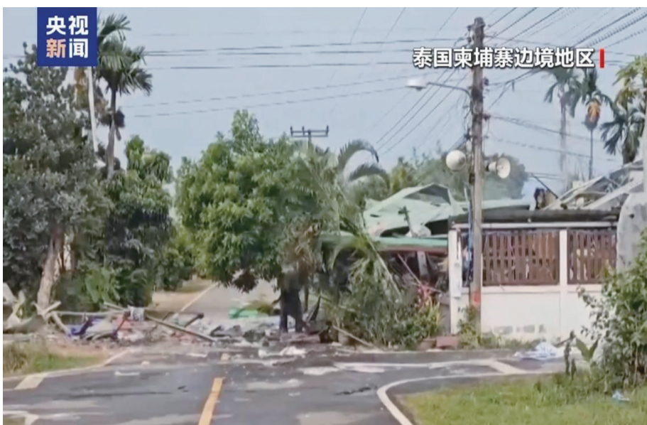
泰柬边境地区房屋道路损毁。
