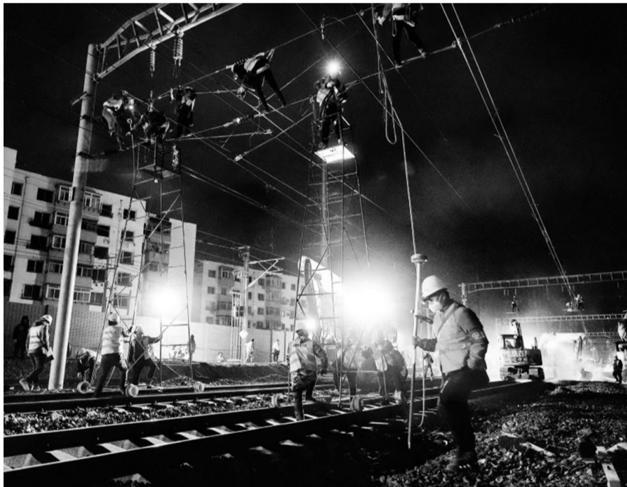
沈山铁路北道增建二线转线施工顺利完成。
