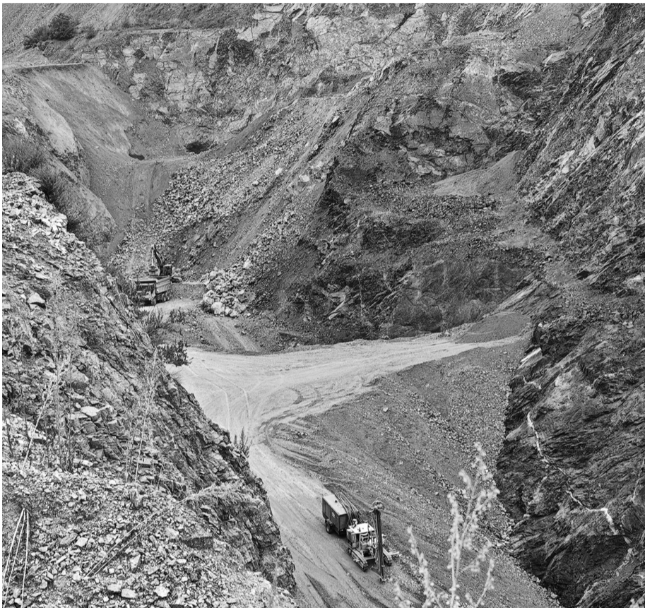
深坑开采点内有挖掘机、运矿车正在装车作业,附近还停放一台专业凿岩台车。 国家矿山安全监察局辽宁局供图
