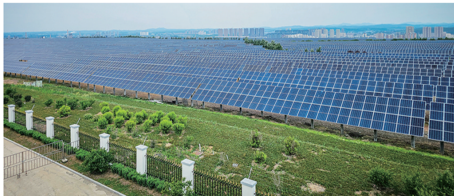
抚矿日晟光伏发电项目年发电超2.85万千瓦时。
