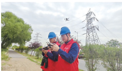
国网阜新供电公司员工利用无人机对220千伏北紫线70-80号塔防洪设施进行巡视。
