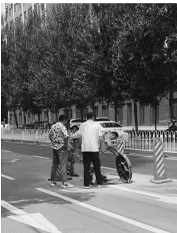
井盖正在修复中。 黄先生供图
