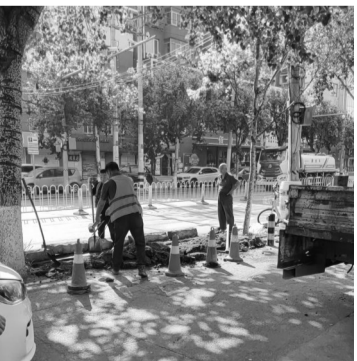
工人们修建方便进出车辆的缓坡。 本报记者 胡婷婷 摄
