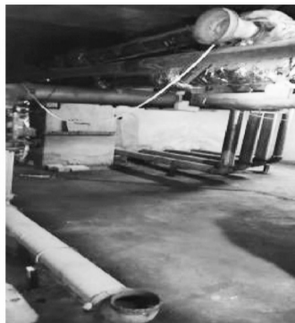
该单位室内消火栓系统、自动喷水灭火系统未保持完好有效，管网被拆除。 沈阳消防供图
