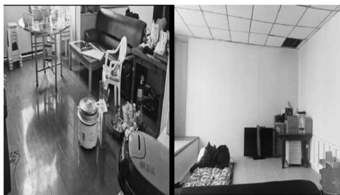
该单位高位消防水箱已拆除，现改为住宅用房。 沈阳消防供图
