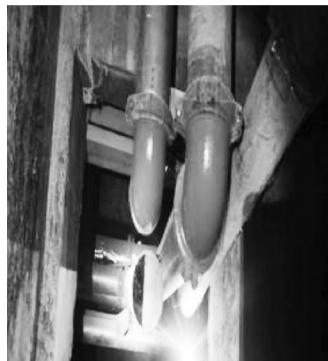
该单位室内消火栓系统、自动喷水灭火系统未保持完好有效，管网被拆除。 沈阳消防供图
