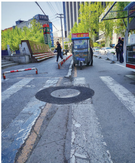
在八经街与光荣街交叉处附近,5个破损塌陷的井盖都已经修复完毕。
