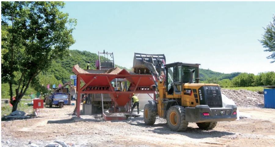
车辆和机械在建设工地上忙碌着。
