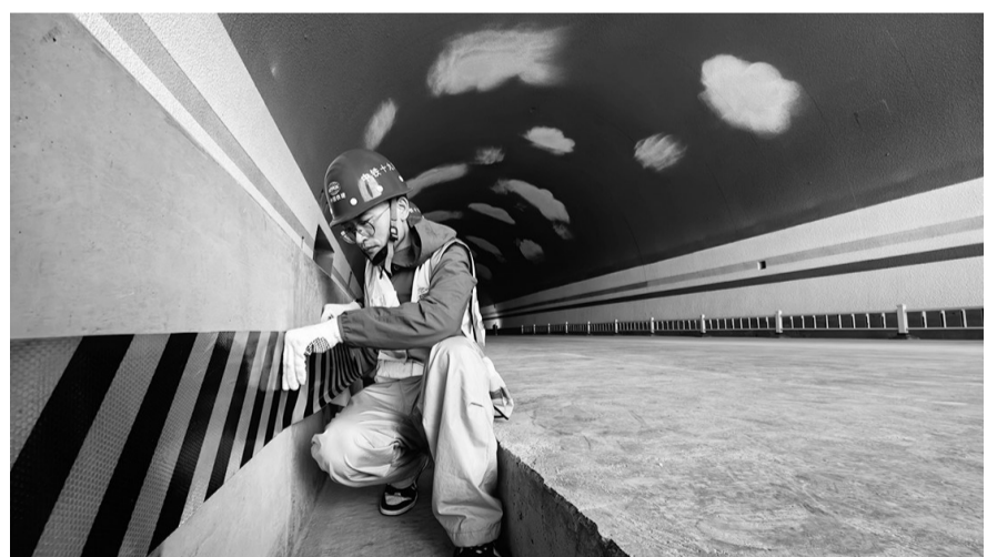
凌绥高速红山隧道出入口，弧形隧道顶特别设计了“蓝天白云”图案，缓解驾驶人员视觉疲劳。
