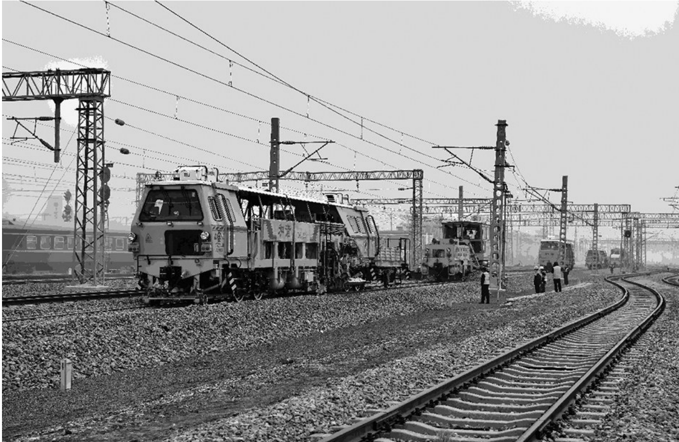
沈铁沈阳工务机械段大型养路机械正在对沈山线进行清筛作业。
