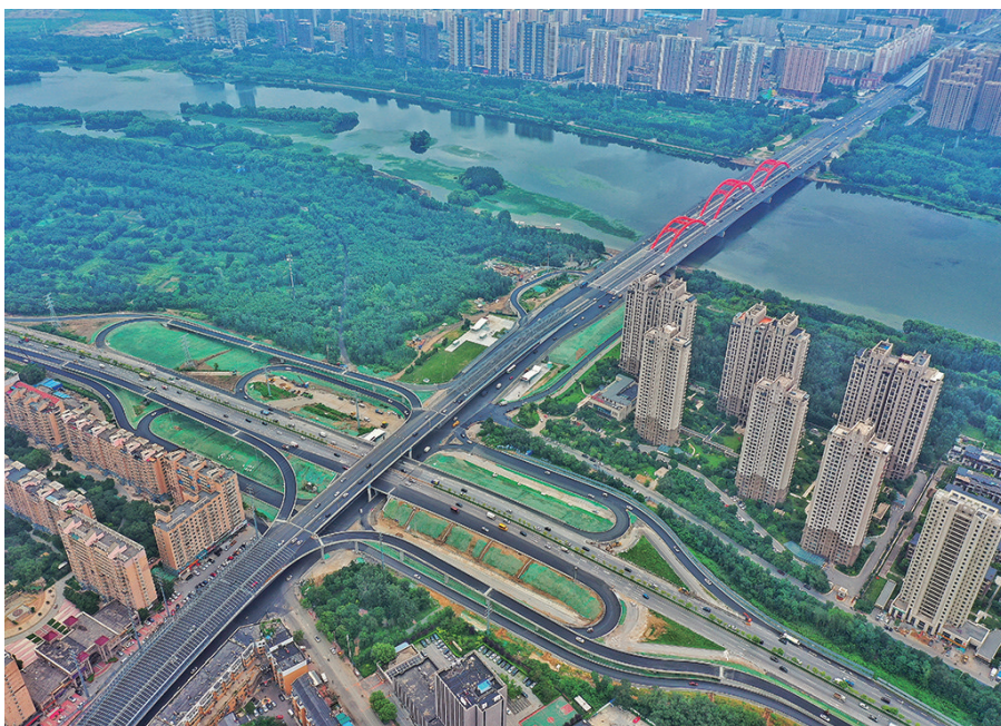
沈阳市长青街快速路。
