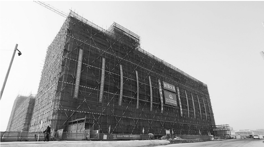
12月5日,沈阳地铁三号线宝马车辆段内的综合楼完成主体结构封顶。 辽沈晚报记者 曲直 摄
