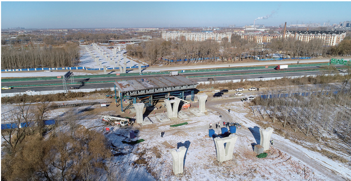
11月30日,沈阳市元江街快速路工程正在施工。
