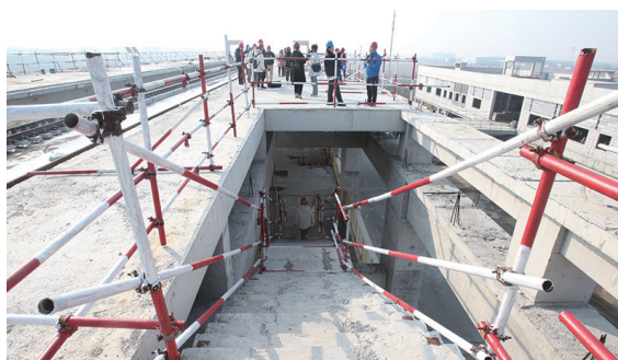
地铁3号线宝马新工厂站 车站及区间主体结构完工 03
