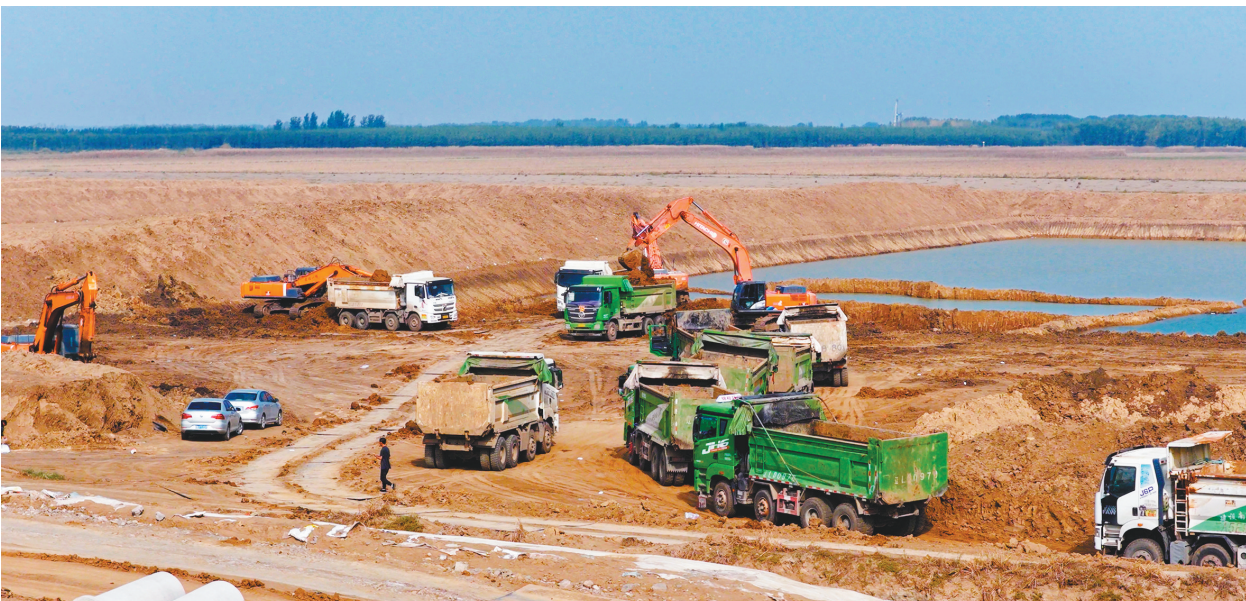
图为施工车辆正在取土料并送往大堤填筑现场。
