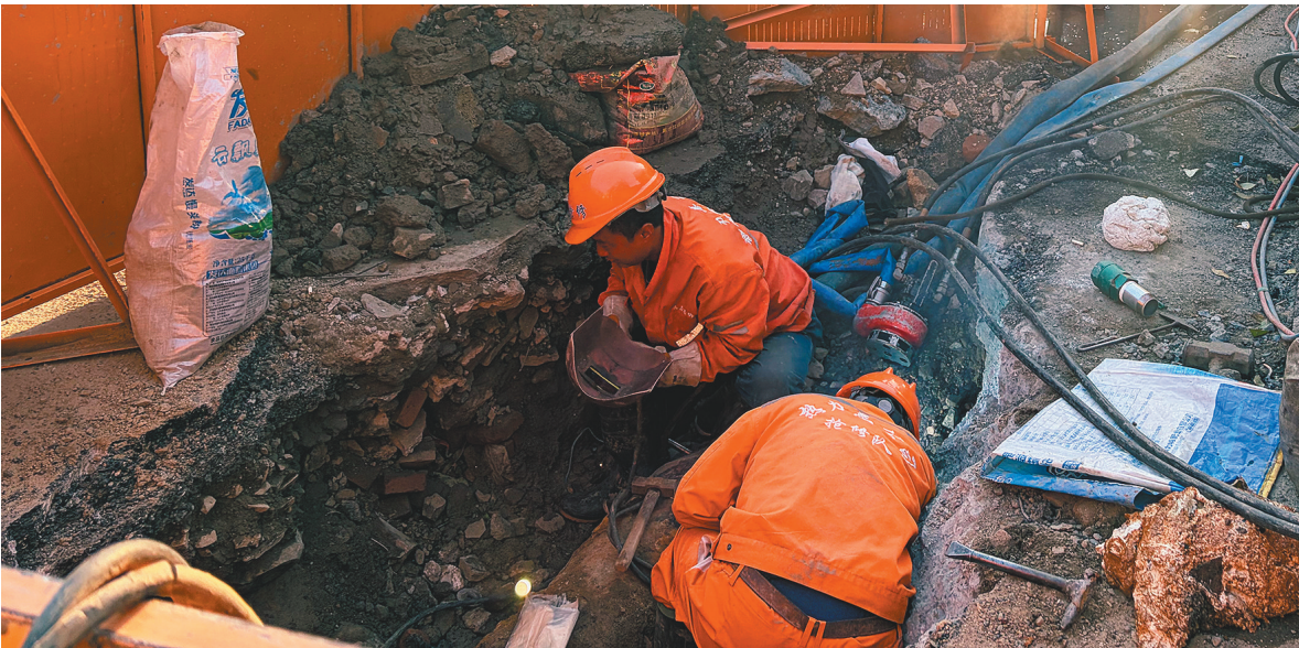
阜新市热力有限公司抢修队在接到求助电话后迅速抵达抢修现场。
