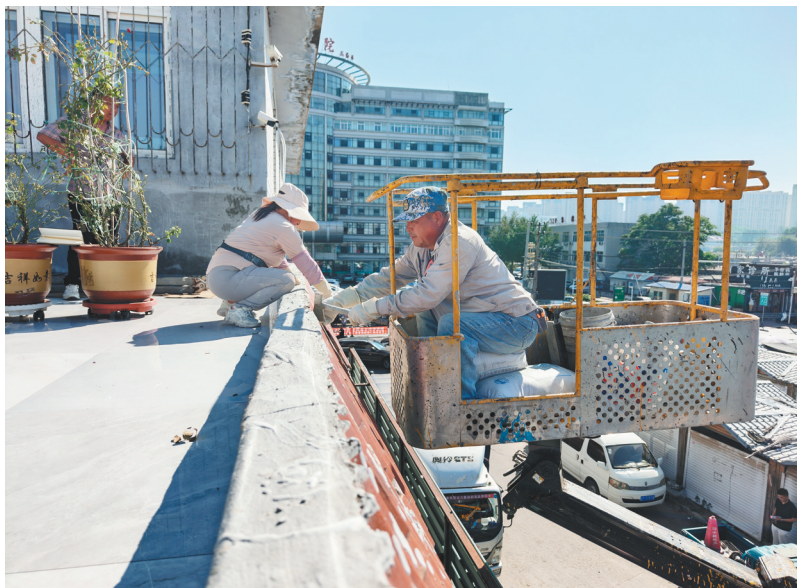
群众“未诉先办”，工人在绥中县和平街修补破损楼顶。
