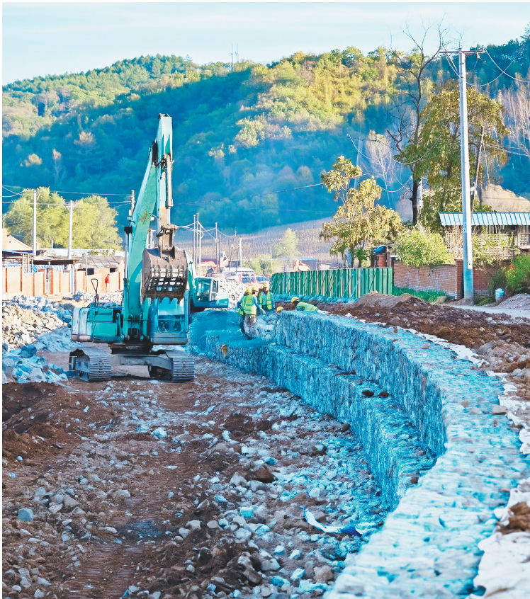
施工人员正在对泄洪河道进行加固施工。
