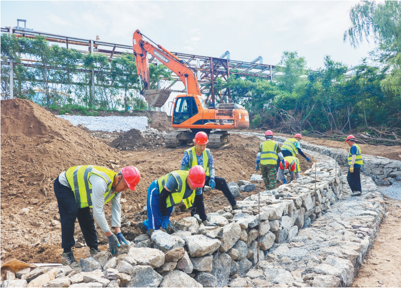
在抚顺高新技术产业开发区受损管廊恢复重建现场,施工人员对泄洪沟渠进行加固。
