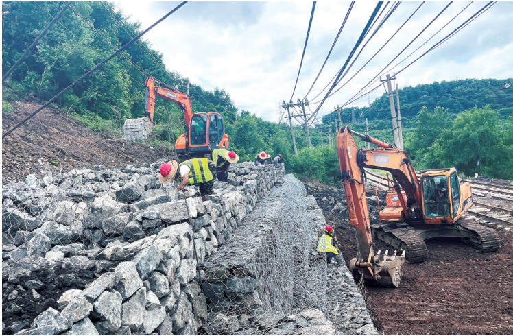
施工人员在西露天矿东段边坡进行加固。
