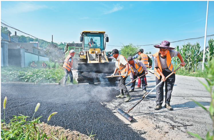
施工人员在修复农村水毁道路。
