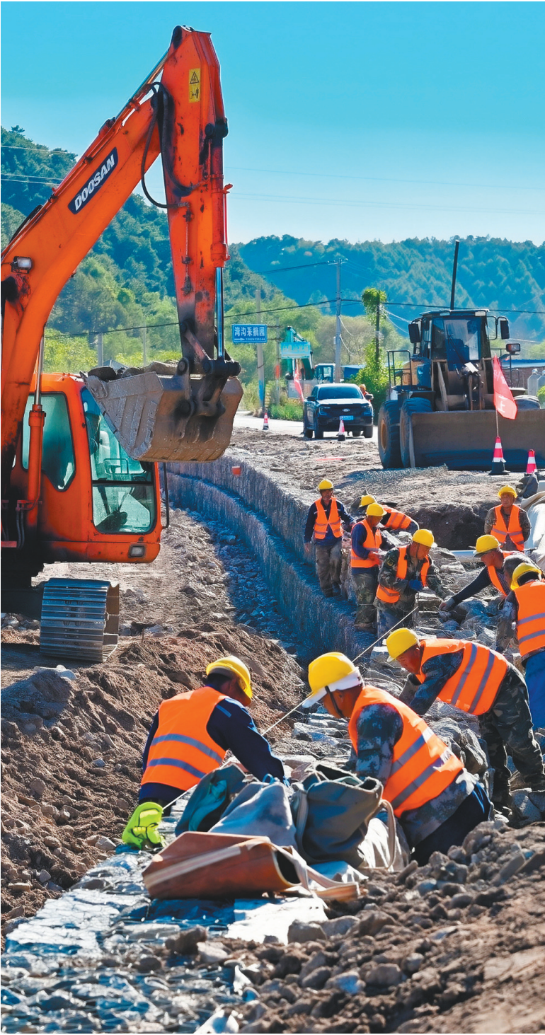
施工人员正在对抚西河水毁河堤进行石笼护砌加固。
