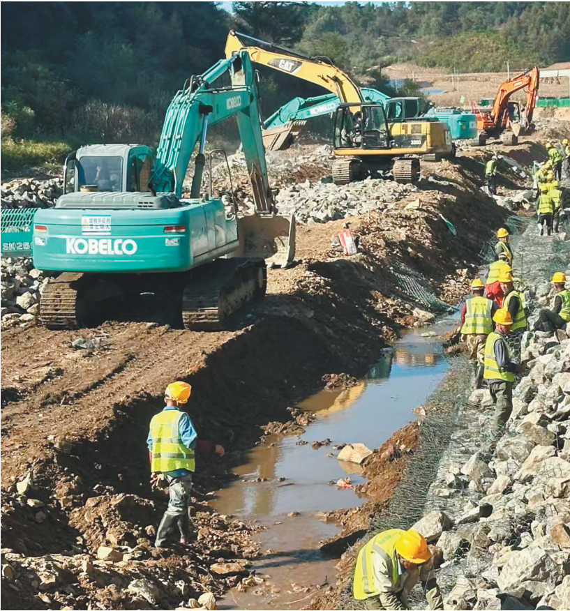
抚顺市东洲区黄金河流域河道治理工程施工现场。
