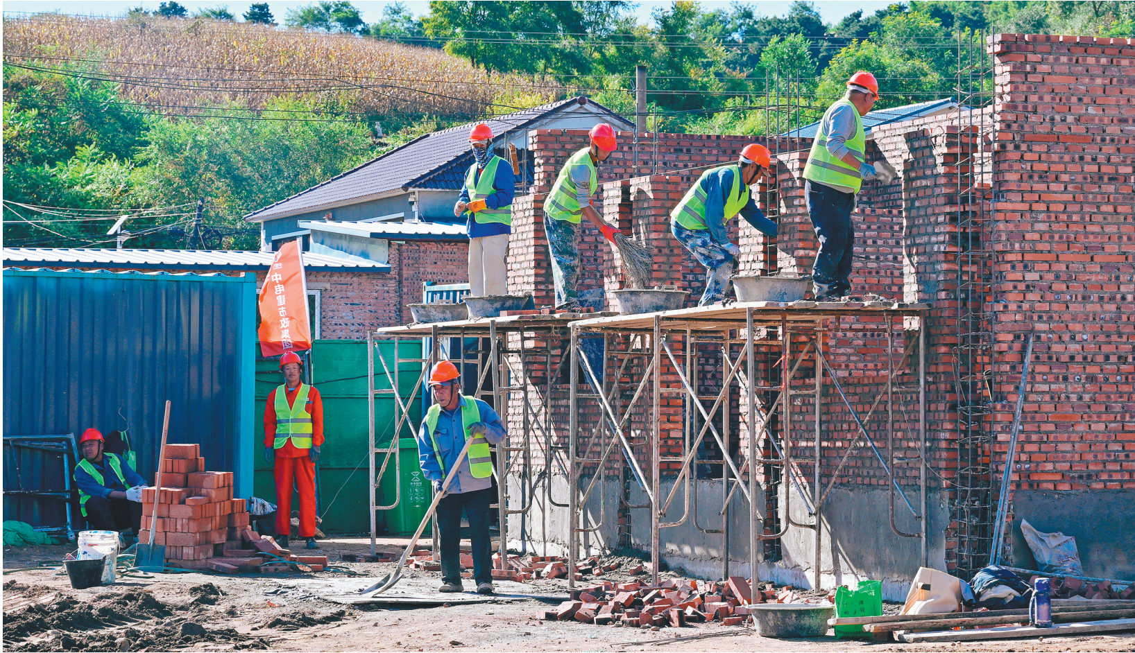
抚顺市顺城区会元乡会元村集中安置点内,施工人员抢抓工期,全力推进房屋建设,让受灾群众早日住进新房。
