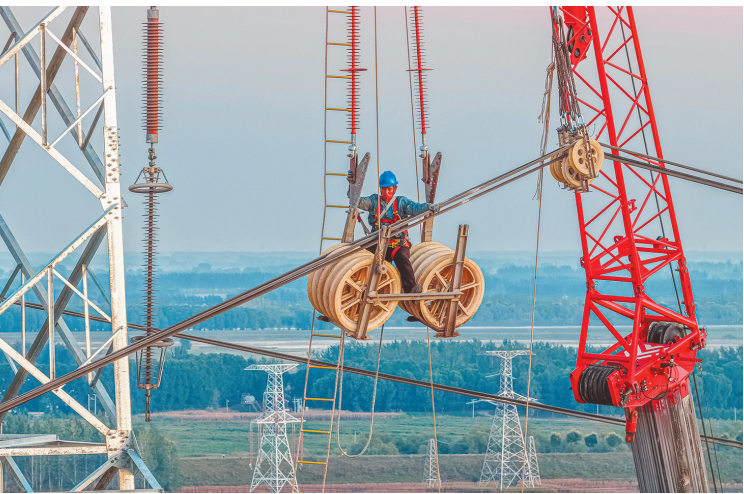
图为电力工人抓紧施工,稳步推进主干网线路焕新升级。 赵琦琳 摄
