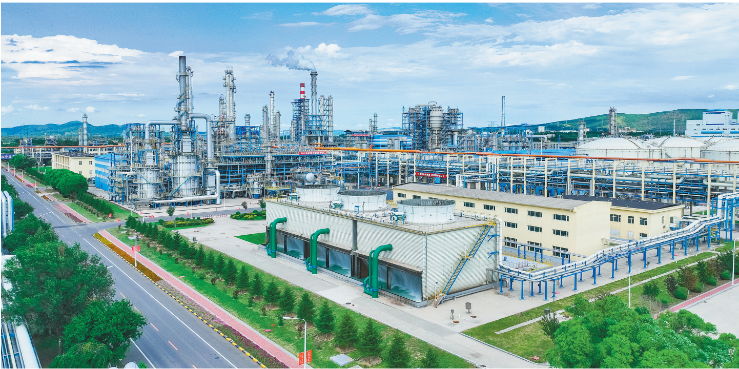
辽阳石化公司厂区装置航拍。
