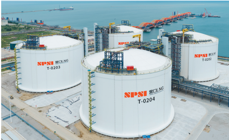
营口LNG接收站项目即将竣工投产。
