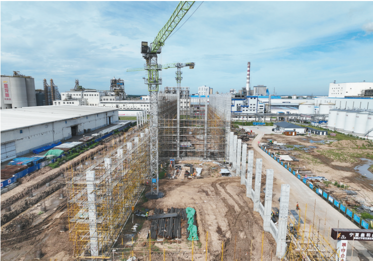
正在建设中的辽宁启生源生物科技有限公司年产6万吨D-阿洛酮糖项目。
