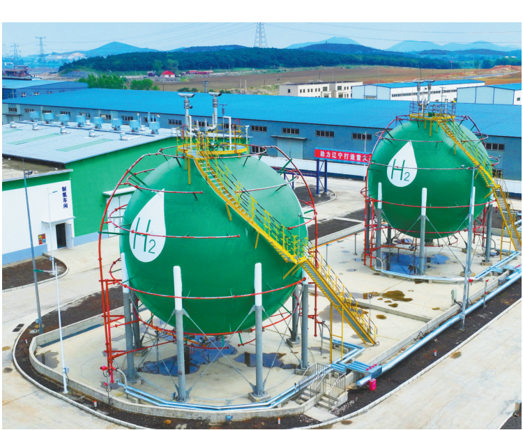
辽宁华电铁岭25兆瓦风电离网储能制氢一体化项目投入运营。
