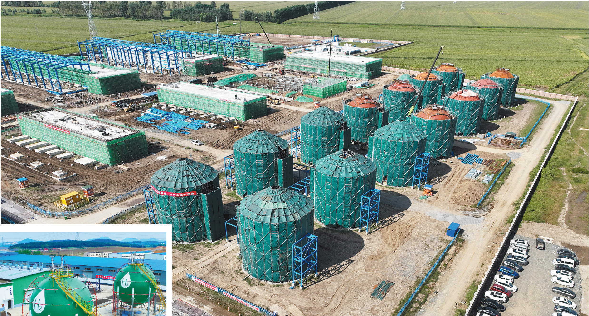
正在建设中的华电调兵山风电制氢耦合绿色甲醇一体化示范项目。
