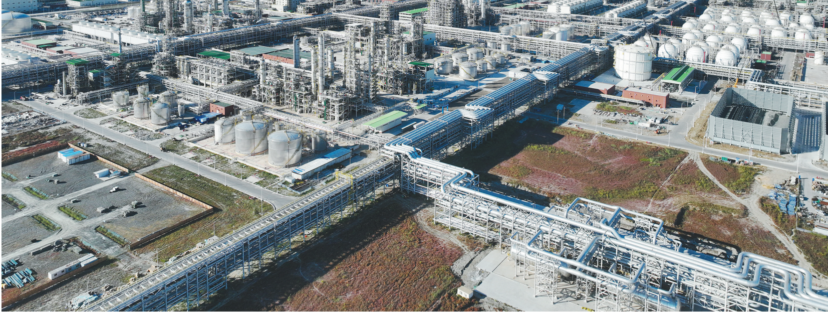
华锦阿美精细化工及原料工程项目现场。 本报特约记者 孙 疆 摄
