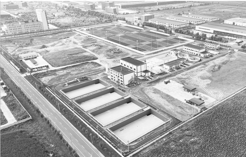
沈阳生物化工产业园正在加紧建设中。
