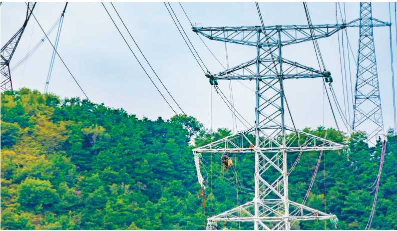
9月1日19时17分,大唐南票风电220千伏送出工程顺利送电,标志着大唐南票风电项目清洁能源外送
