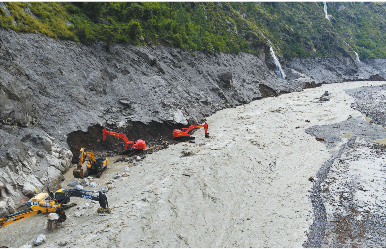
8月31日,中国安能集团组织大型机械在国道G216西藏日喀则市吉隆镇至吉隆口岸路段持续开展抢通作业。 新华社发
