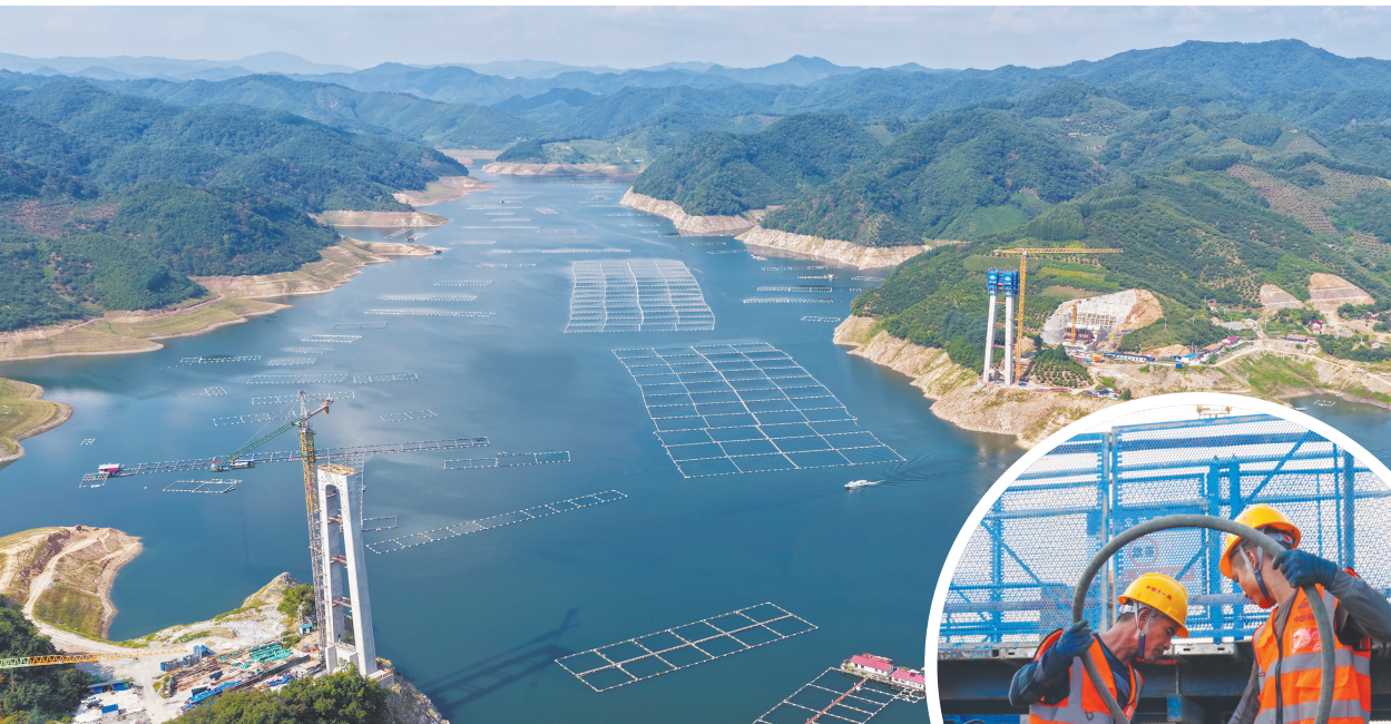
大图:G331国道大久才江口特大桥正在建造中。 小图:工人正在进行混凝土浇筑作业。
