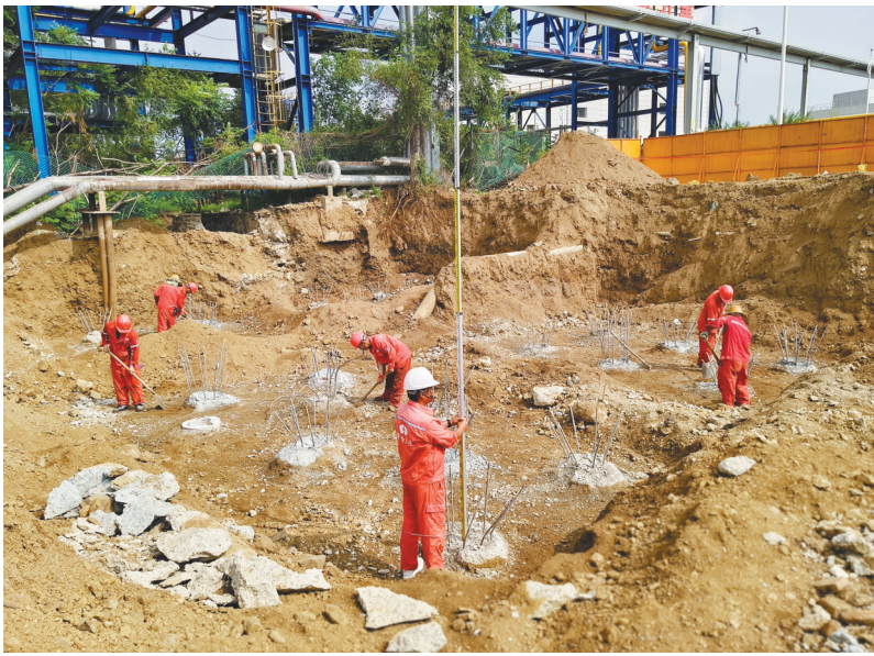
抚顺高新技术产业开发区受损管廊恢复重建现场。 本报记者 崔振波 摄
