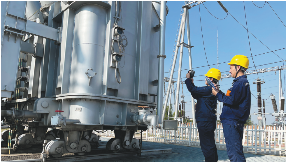
用电高峰时段,国网辽阳供电公司运维人员在铁西220千伏变电站开展高温特巡,细致排查设备发热隐患,全力保障电网安全稳定运行,扎实做好迎峰度夏保供工作。 吴扬 摄
